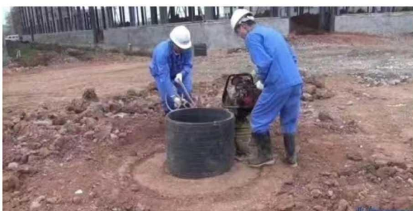
回填夯实流程
